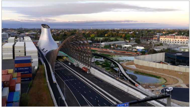
그림 2 호주 빅토리아주 West Gate Tunnel 민자도로
