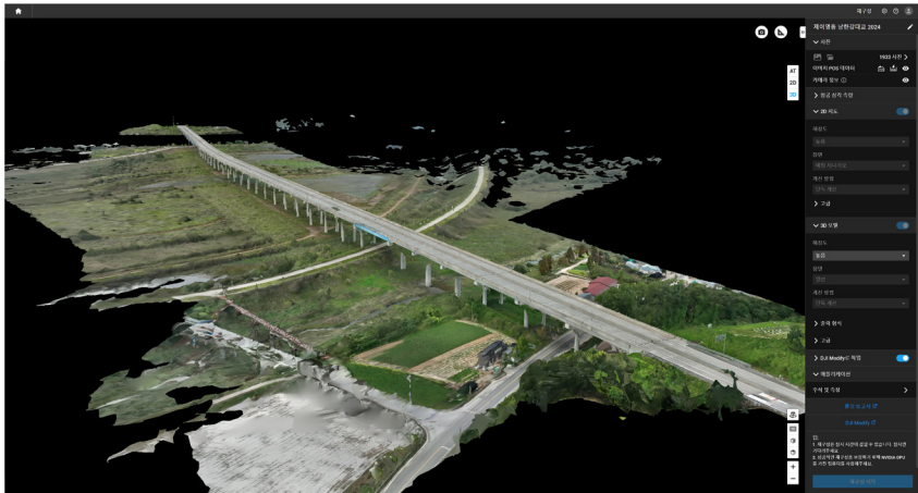
[그림 8] 드론활용 교량 3D 점검 사례
