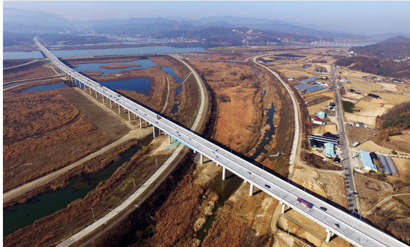
[그림 11] 광주원주고속도로 중 남한강대교 전경
